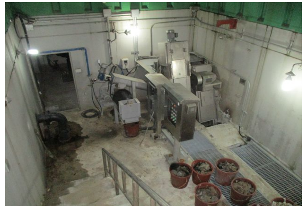
침사지 내부 전경
