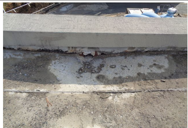
옥상층 바닥 표면박리 ( A=1.5\text{m} \times 1.0\text{m} )
