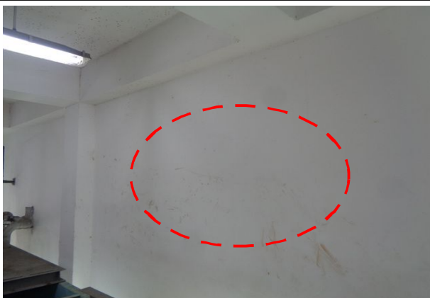
내부 벽체 마감 망상균열 ( A=1.0\text{m} \times 1.0\text{m} )
